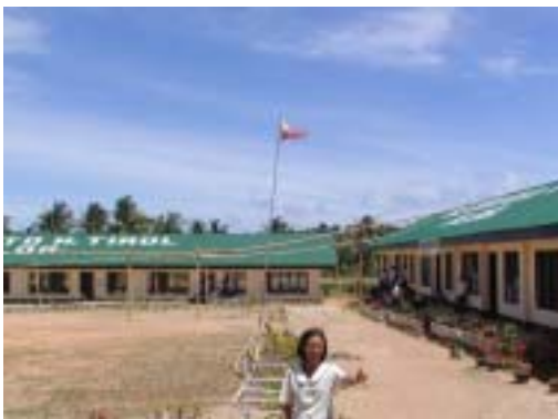
コンクリートでできた校舎
